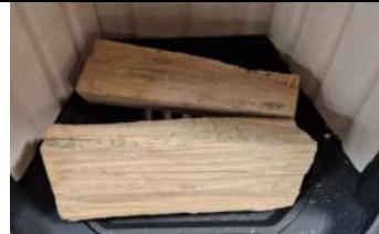
Beim Nachlegen vermeiden Sie das Austreten von Rauchgasen und eine Ascheverwirbelung, indem Sie die Feuerraumtür sehr langsam öffnen.
