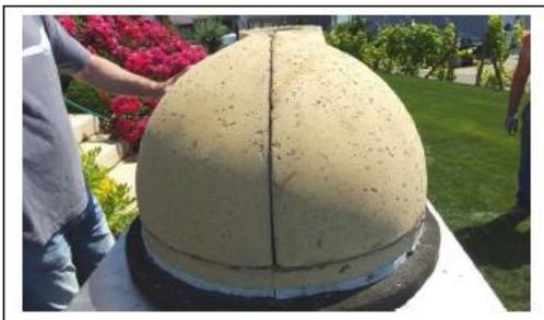
Linkes Ofengewölbe auf Mörtel aufsetzen und anpressen.
