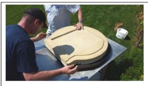
Bodenplatte einteilig auf Calciumteile legen, vorne bündig
