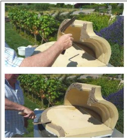
Rechte Seite von Ofengewölbe und linke Bodenplatte mit Mörtel versehen, nicht zu dick auftragen es gibt ca. 2 mm Pressfugen.
