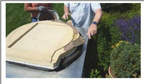
Ca. 2 kg Mörtel mit sauberem Wasser intensiv mischen, nur so viel Mörtel anmachen der in 15 Min. verarbeitet werden kann, Zugabe von Wasser ab Abbindezeit ist verboten. Rechte Seite von Bodenplatte mit Mörtel versehen, nicht zu dick auftragen es gibt ca. 2 mm Pressfugen.
