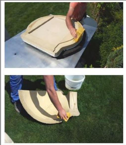
Teile die mit dem MC-Mörtel vermörtelt werden, mit sauberem Wasser und Schwamm anfeuchten
