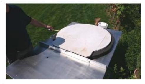
Calciumplattenteile (weiss) auf Schaumglas legen rundum ca. Abstand von 4 cm, Front bündig
