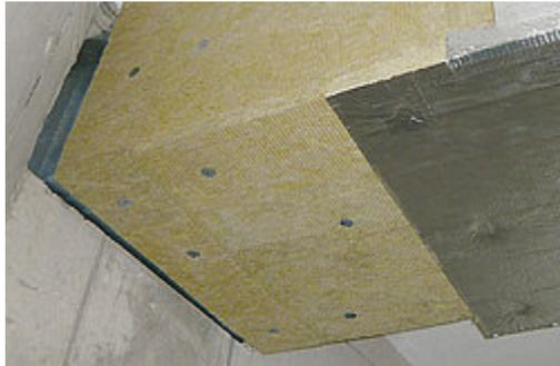
Druckfeste, formstabile Dämmplatte für den Hochtemperaturbereich.
