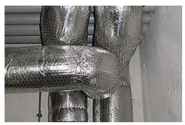
Alubeschichtete Dämmmatte für den Hochtemperaturbereich.
